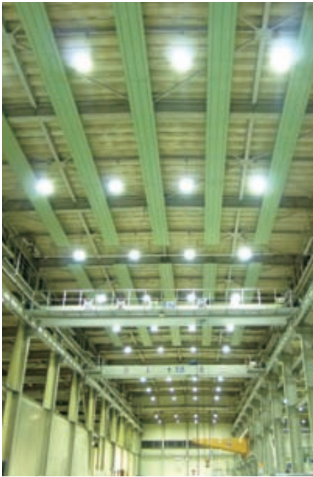
【工場照明】ホクショー株式会社(白山工場)
