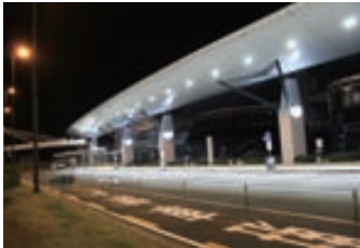
【街路照明】 高松空港
