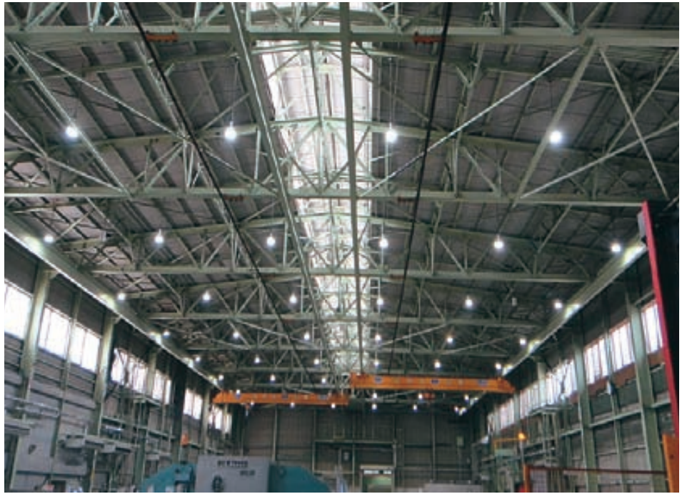
【工場照明】(株)日本無線電機サービス社
