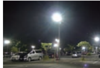
【駐車場照明】 近畿大学附属病院
